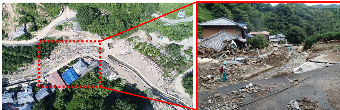
2級立間川水系 本村川 被災状況
