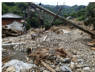
本村川 土砂埋塞による氾濫状況
