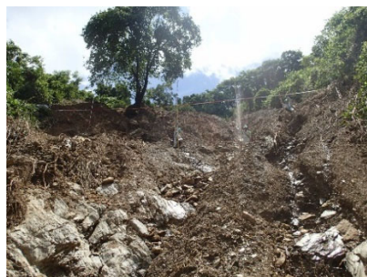
南柏川 流域上部での斜面崩壊状況
